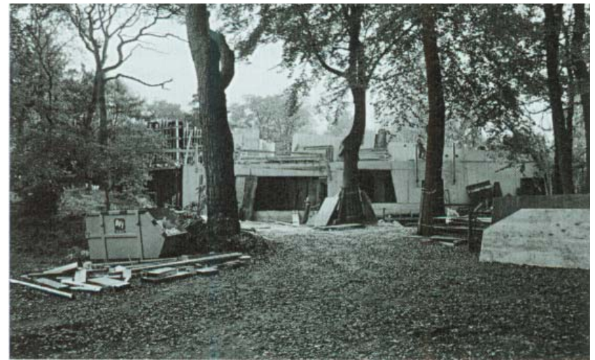
Blick vom Waldeingang während der Bauphase 5
