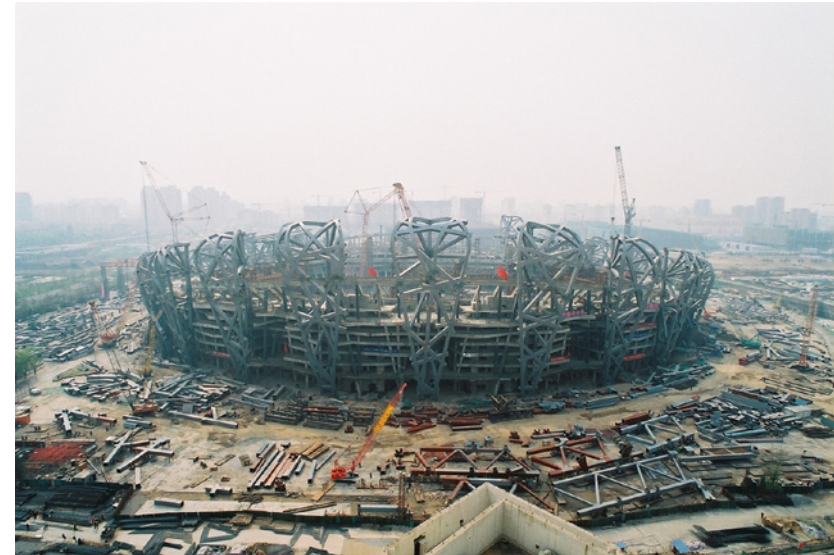
Abb. 9: Montagearbeiten rund ums Stadion: Die Hauptträger stehen bereits
