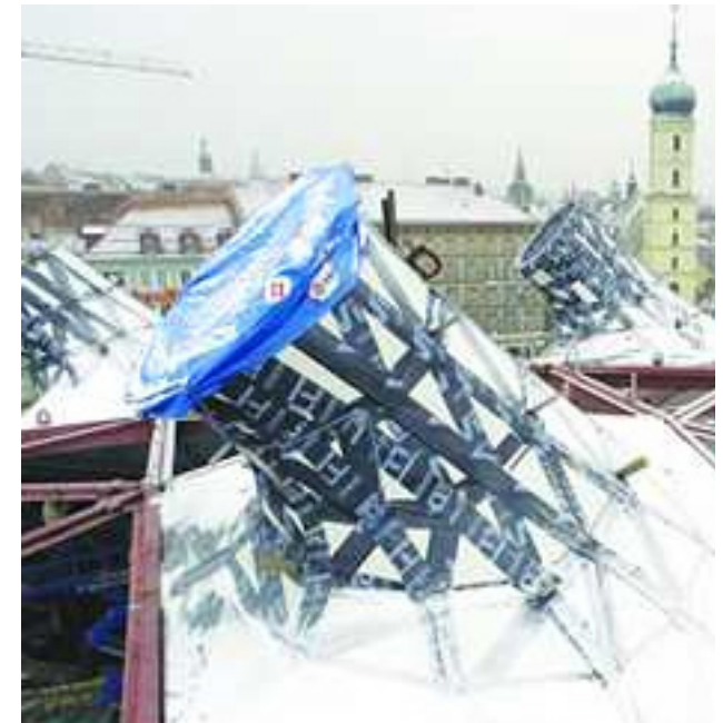
"Nozzle" im Bau
