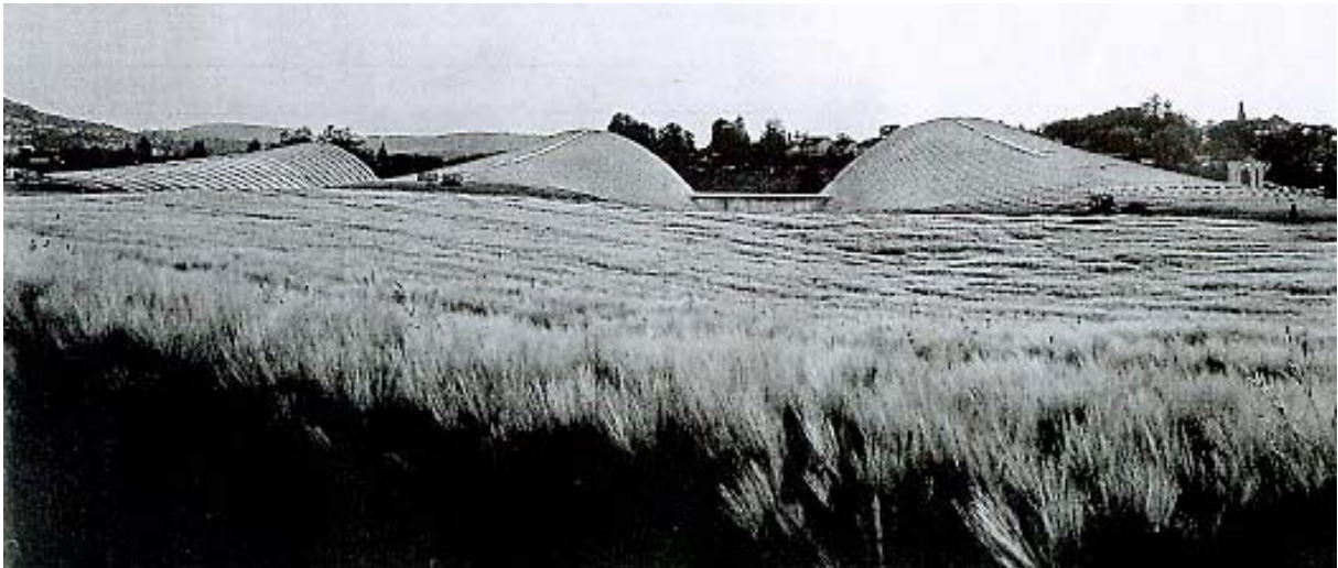
Abb. 1: Ostansicht Paul Klee Zentrum, Bern
