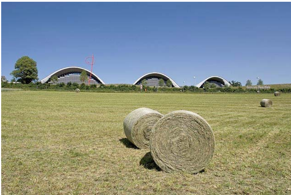
Abb. 2: Westansicht Paul Klee Zentrum, Bern
