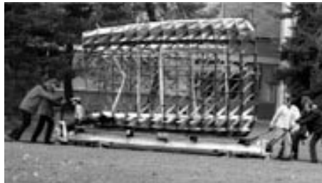
Aufbau: Der Zusammenbau erfolgt sequentiell nach einem vorgegebenen Muster. Element rastet in Element. Ring folgt auf Ring und wird mit Edelstahlnieten zusammengefügt. Das Gesamtprojekt wird in zwei Segmenten erstellt, die als ganzes zusammengefügt werden.
